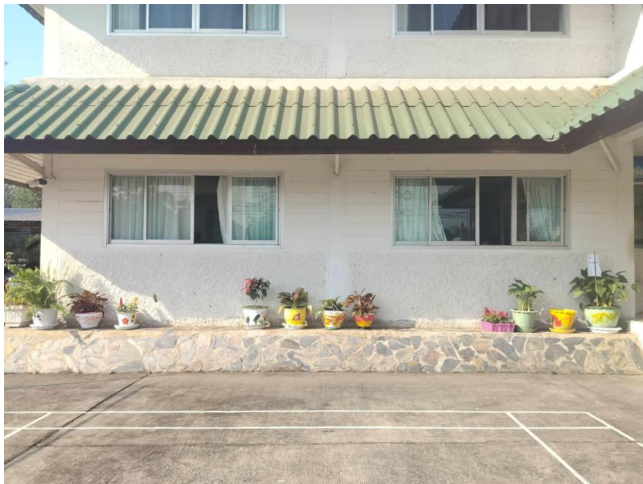
รูปภาพที่ 4 บริเวณข้างอาคารสำนักงาน
