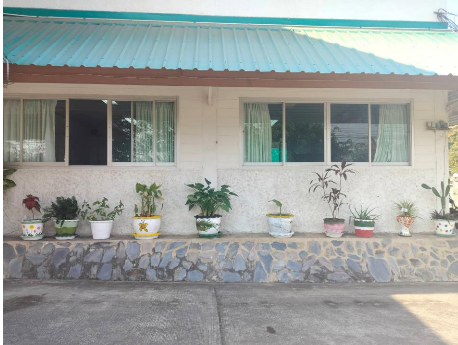
รูปภาพที่ 3 บริเวณข้างอาคารสำนักงาน
